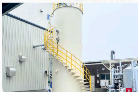
φ2500サイロ製作 現地設置施工
