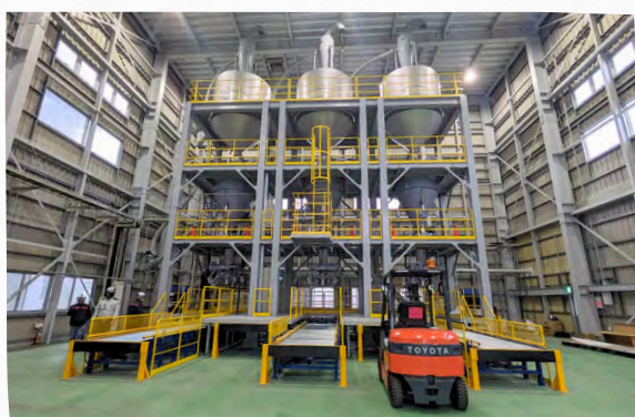
タンク・架台製作 現地組立設置施工
